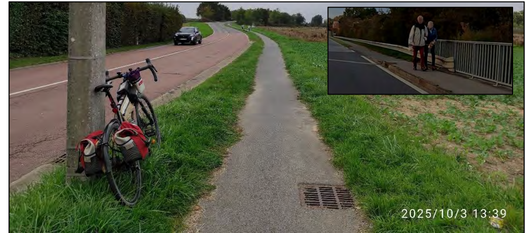
Exemple Rle St-Martin : Traversée piétonne sans abaissé de trottoir et ne respectant pas les principes généraux d'aménagement des passages piétons (orthogonalisation, distance à traverser, ...)
