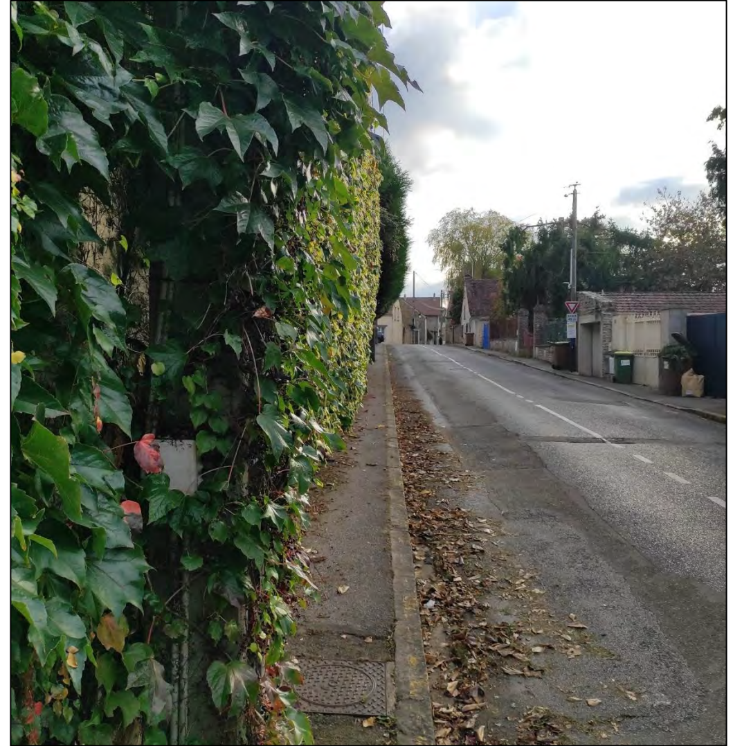
Rue Labarraque : Problématique identique sur le trottoir Est
