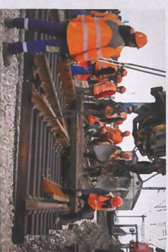
Renouvellement d'aiguillage
